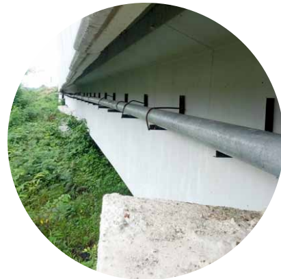
Kabel gentian optik dipasang untuk menyediakan perkhidmatan jalur lebar yang lebih baik sejajar dengan permintaan untuk perkhidmatan LTE.
